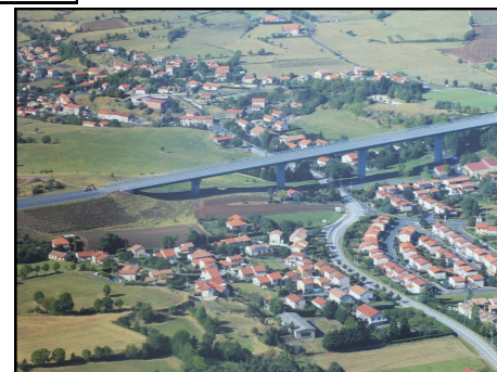
Le viaduc de Taulhac (photo DREAL)
